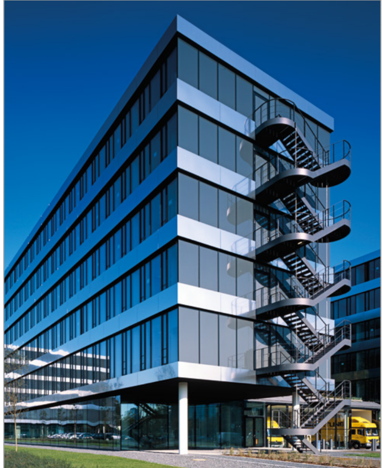
Klebeverbindungen wurden inzwischen auch im Fassadenbau erfolgreich eingesetzt. Foto: Ebener, Bad Marienberg (D)
